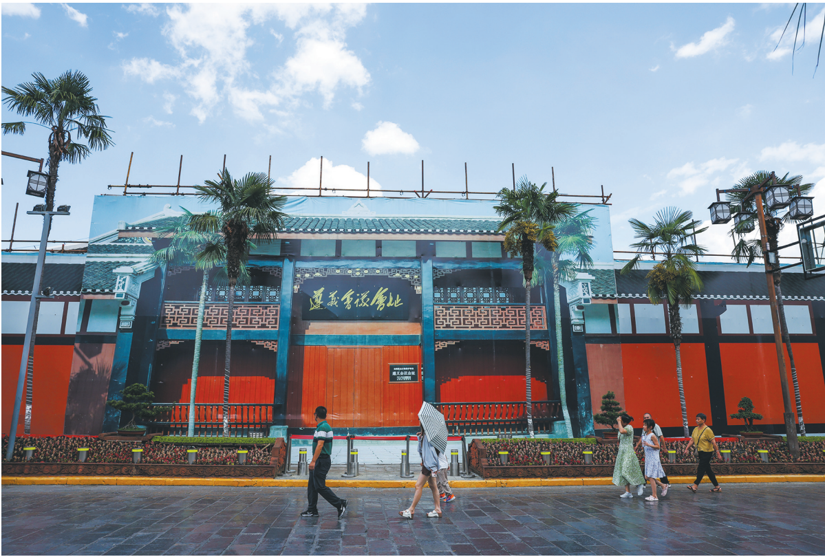
近日，遵义会议会址保护修缮项目持续推进，目前工程即将完工。图为正在修缮的遵义会议会址大门。 本版稿件图片除转文外均由新华社发
