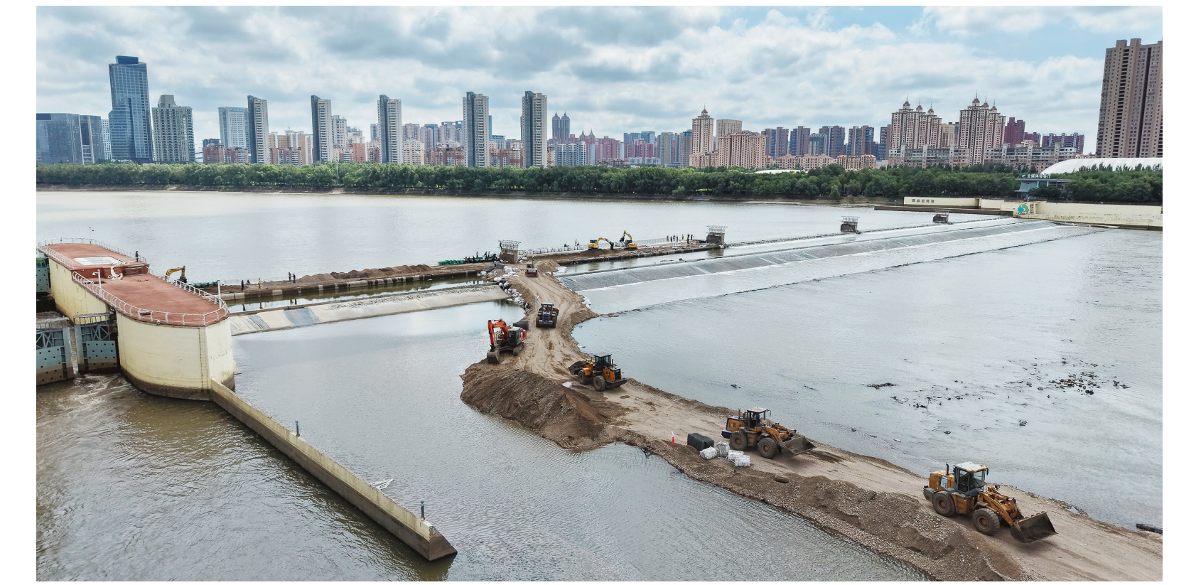
筑牢防汛“安全堤” 近日,为提升拦河坝防洪调蓄能力,守护沿岸群众生命财产安全,沈阳市对浑河拦河坝启动全方位修缮加固施工作业,浑河河面上机械轰鸣,施工人员加紧施工,全力筑牢防汛“安全堤”。 图为8月7日,施工人员正在浑河进行拦河坝修缮作业。 本报记者 白琳 摄
