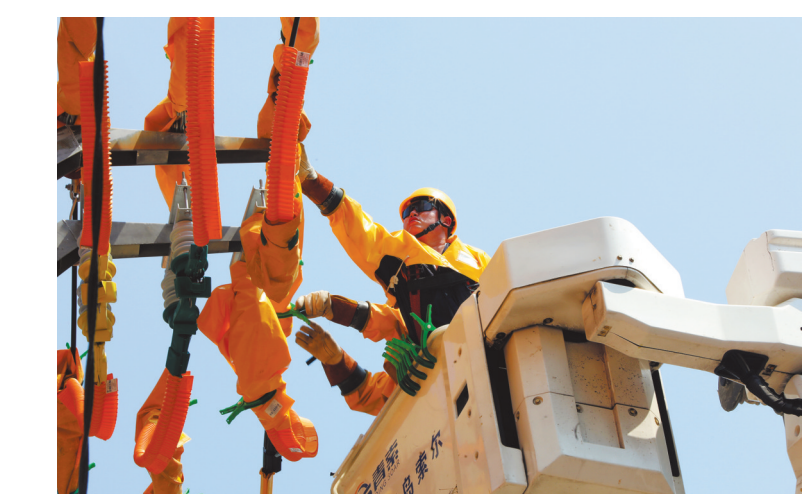
图为国网沈阳供电公司带电作业中心员工在和平区宜春小区附近开展带电作业。 史灵丰 摄
