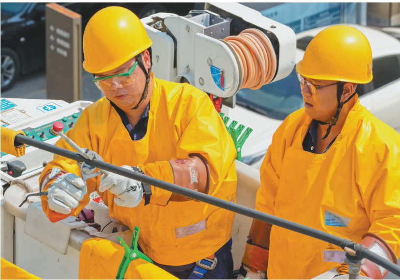
国网鞍山供电公司员工在10千伏达恒线开展不停电连接引线工作。 赵琦林 摄
