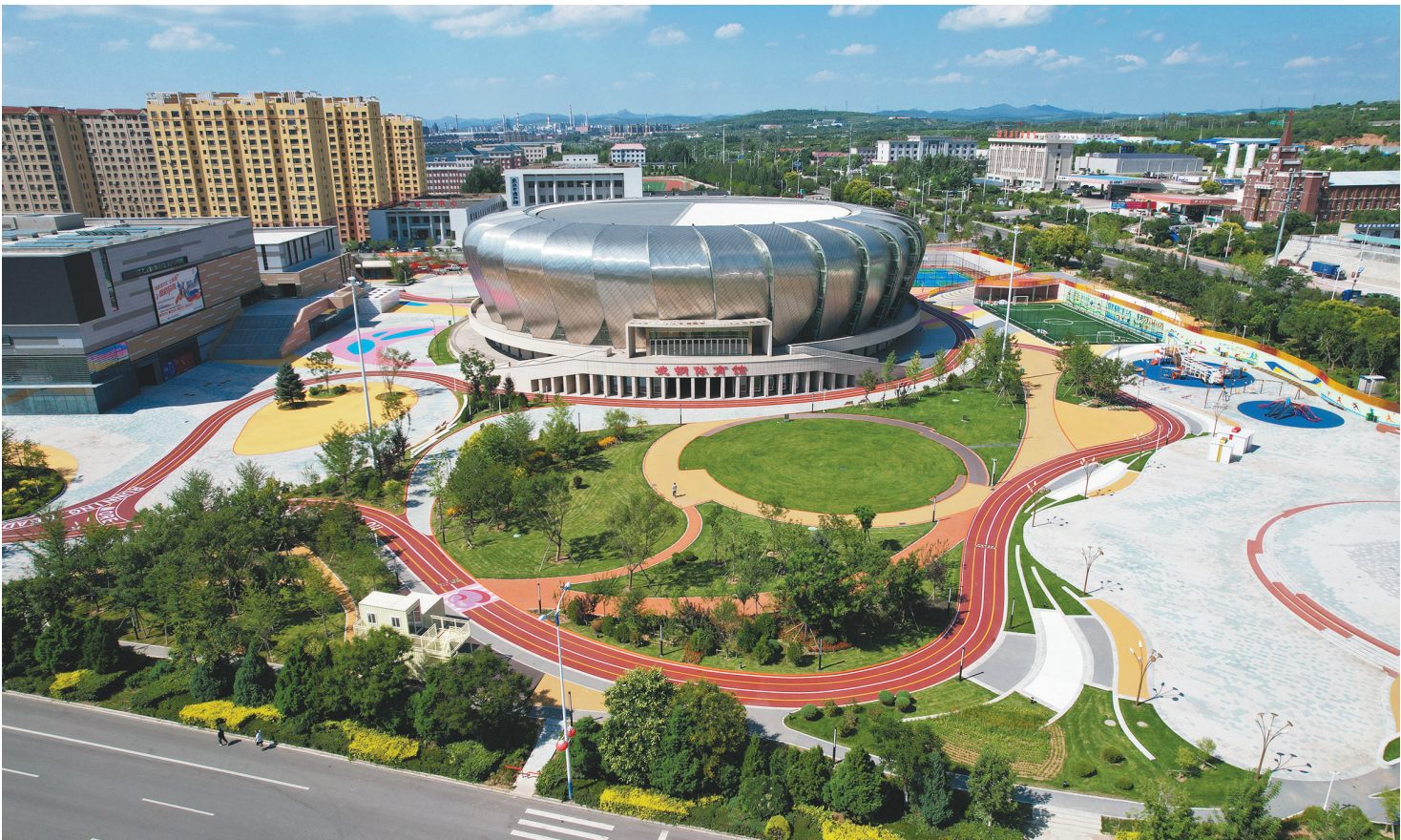
凌钢体育馆建成投用。
