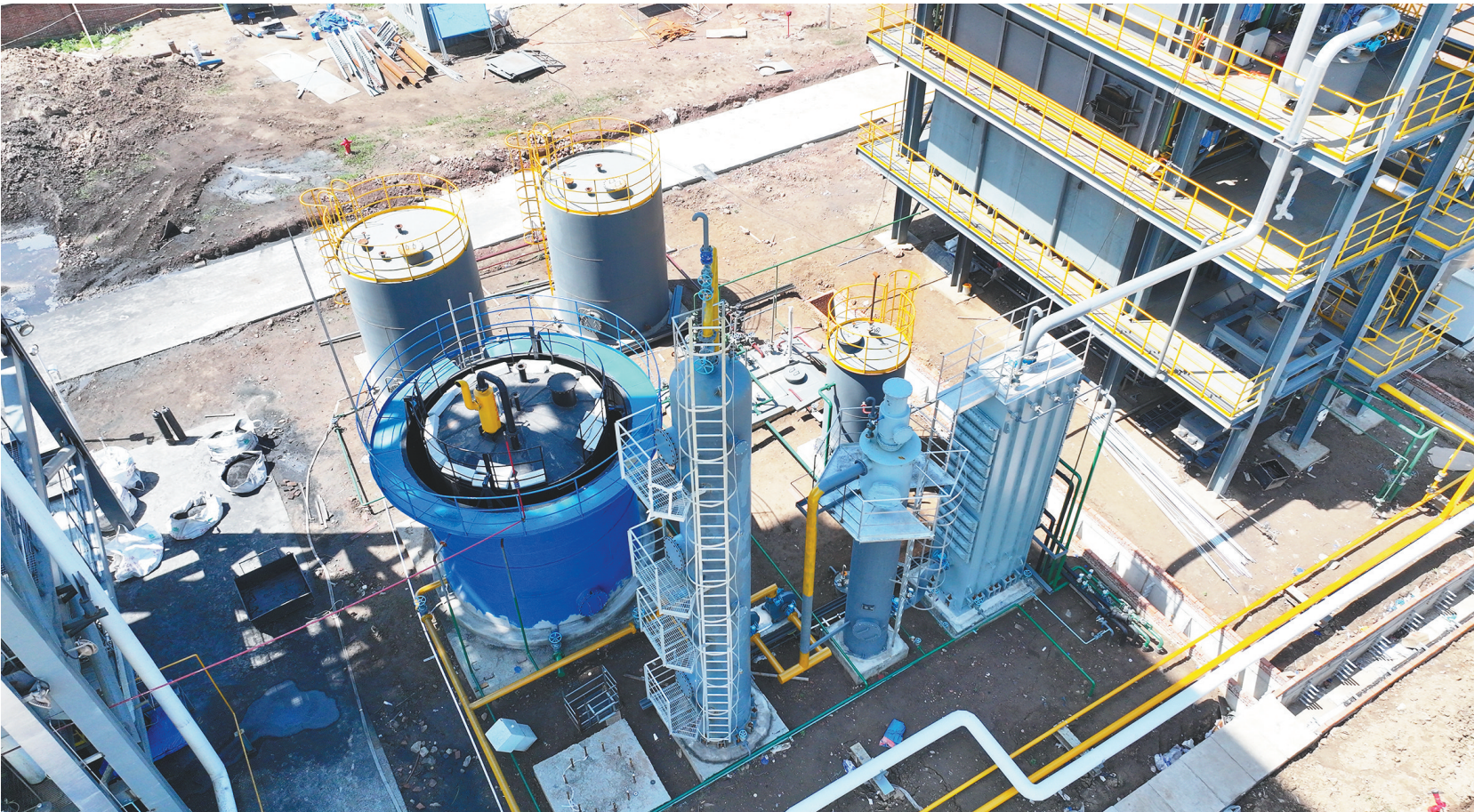
沈化中试(调兵山)化工有限责任公司固体碳基资源热解气化中试项目进入工程收尾阶段。 本报特约记者 李林峰 摄
