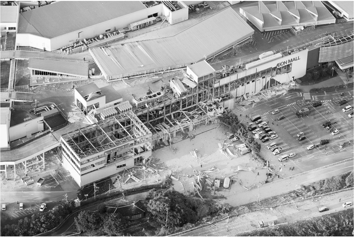
图为7月28日,在日本熊本县,地震导致一处购物中心建筑物受损。
