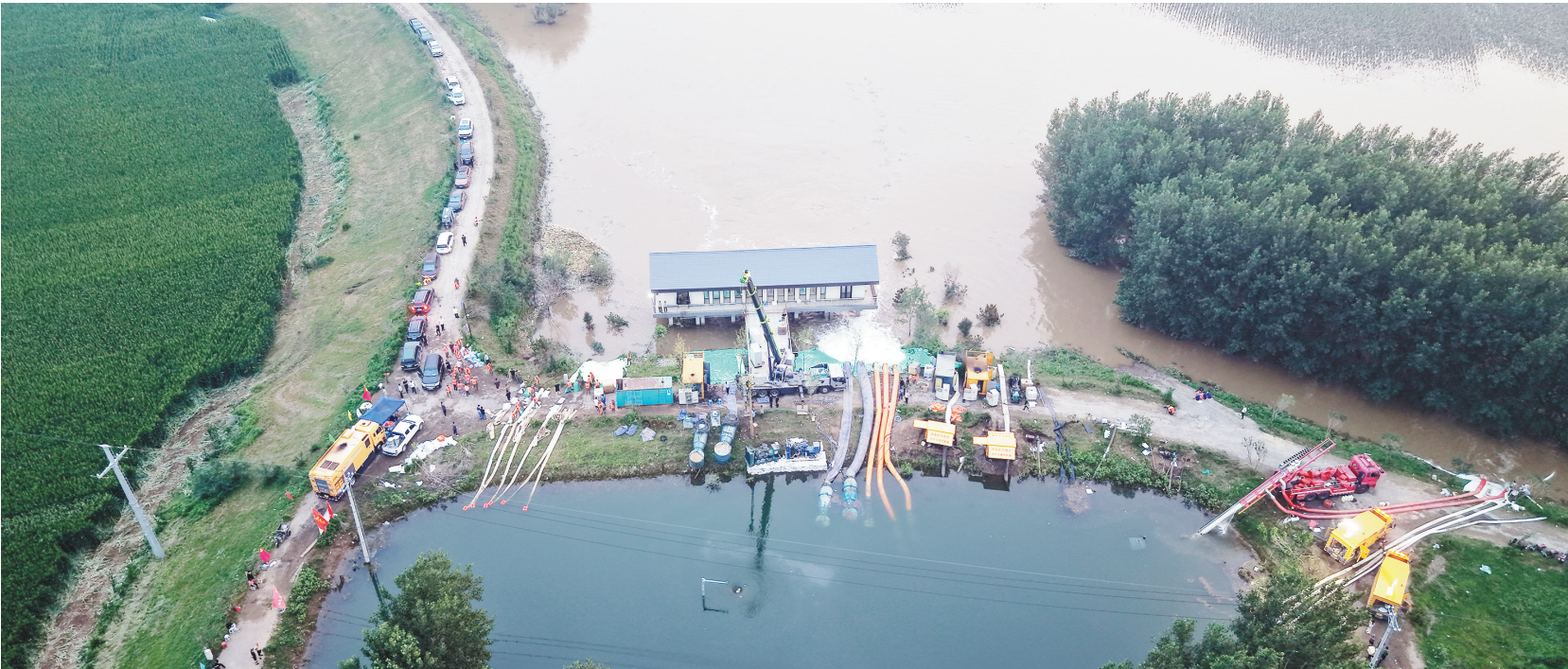
施工人员正在小北河镇浑河段加紧排水、巩固堤坝。
