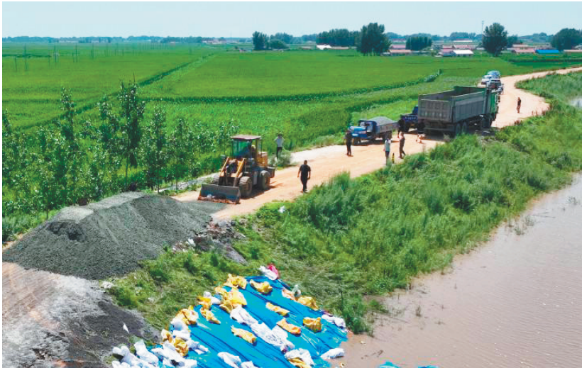
在唐马寨镇,施工队伍正在抢修堤坝。
