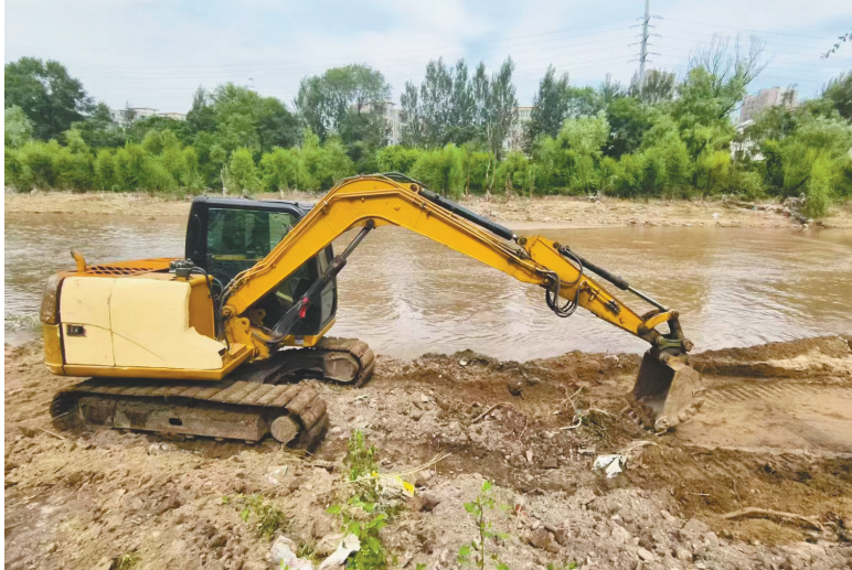
顺城区出动大型机械对抚西河进行清淤。
