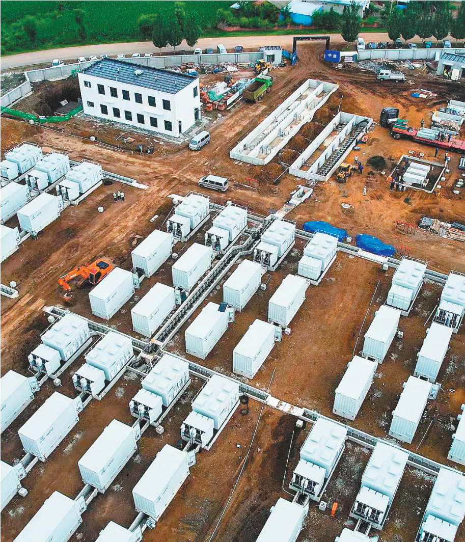
中能国宏100MW/200MWh独立储能电站项目已经进入设备电气安装攻坚阶段。
