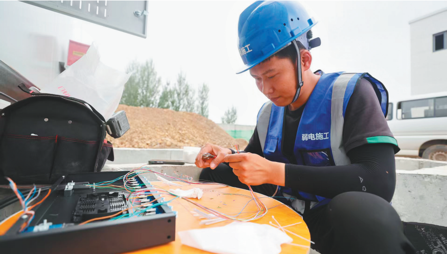
在中能国宏100MW/200MWh独立储能电站项目施工现场，工人正在调试设备。
