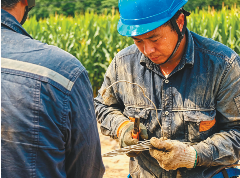
7月16日，国网本溪供电公司赴抚顺抢修队正在对10千伏阿及线良科场分15—24号换位导线进行紧线作业。 张思诗 摄
