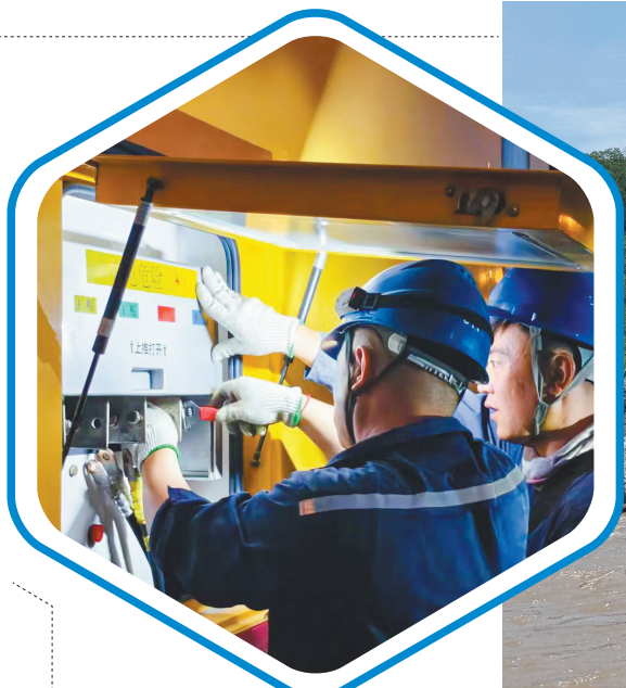
7月15日晚，国网鞍山供电公司支援抢修队伍在沈阳市苏家屯区浑河国际城小区对发电车进行线缆接引。 周思宇 摄
