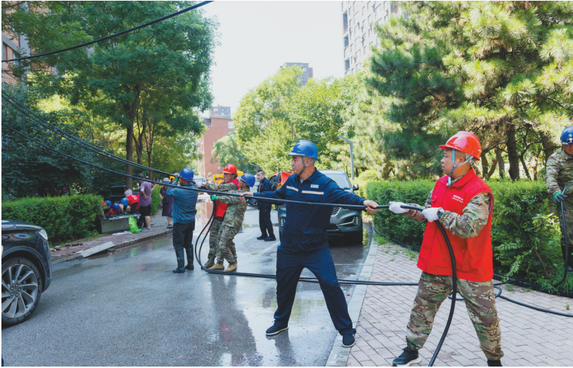
7月15日，国网黑龙江省电力有限公司支援队伍与国网沈阳市大东区供电分公司在沈阳水晶城小区一期进行恢复供电抢修。 刘子健 陈 龙 摄
