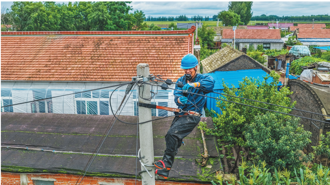
国网鞍山供电公司员工在台安县侯家村为村民连接进户线。 赵琦林 摄
