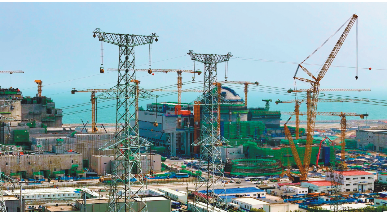
图为徐大堡核电500千伏送出工程(一期)现场。
