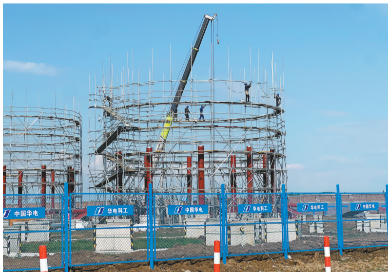
在辽宁华电调兵山风电制氢耦合绿色甲醇一体化示范项目建设现场，工人正在半空中搭建脚手架。
