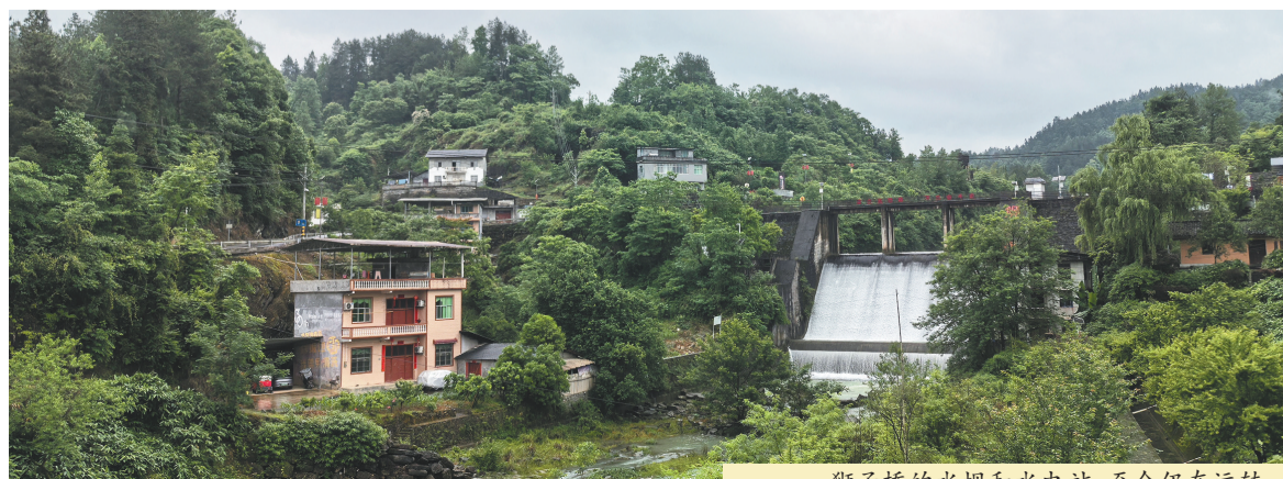
狮子桥的水坝和电站,至今仍在运转。
