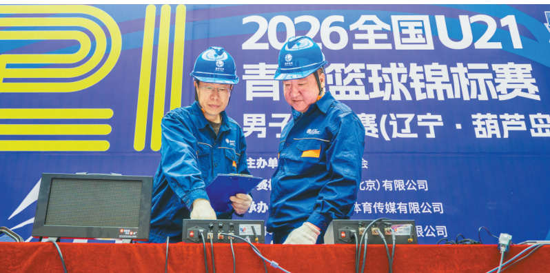
国网葫芦岛供电公司工作人员检查场馆话筒音响等关键用电设备，做实做细赛事保电工作。 牟超摄
