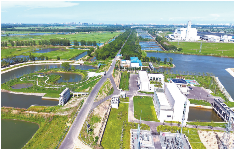
于岗子排水站俯瞰图。
