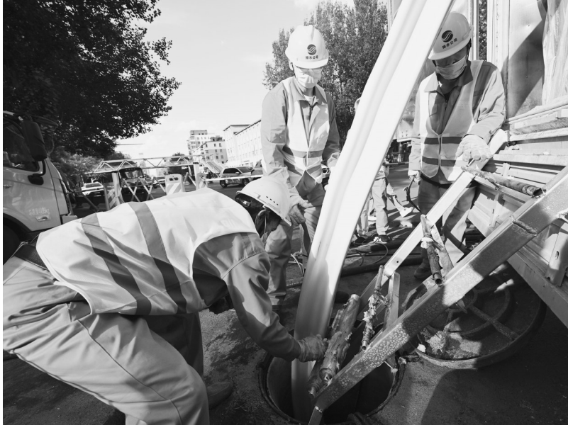
技术人员运用热塑成型工艺，对管道进行结构性修复。 本报记者 杨靖岫 摄
