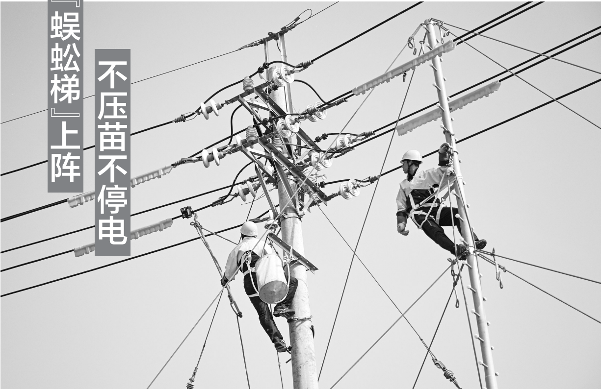
工作人员在电杆上开展引流线搭接工作。
