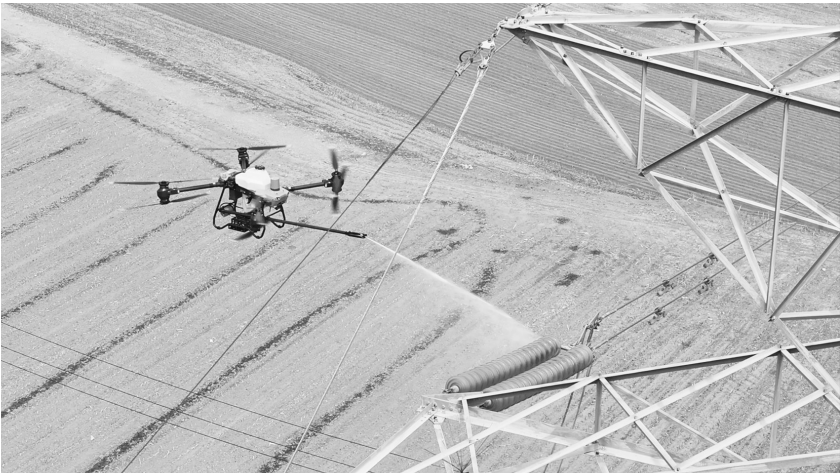
无人机带电水冲洗装置在开展水冲洗除污作业。
