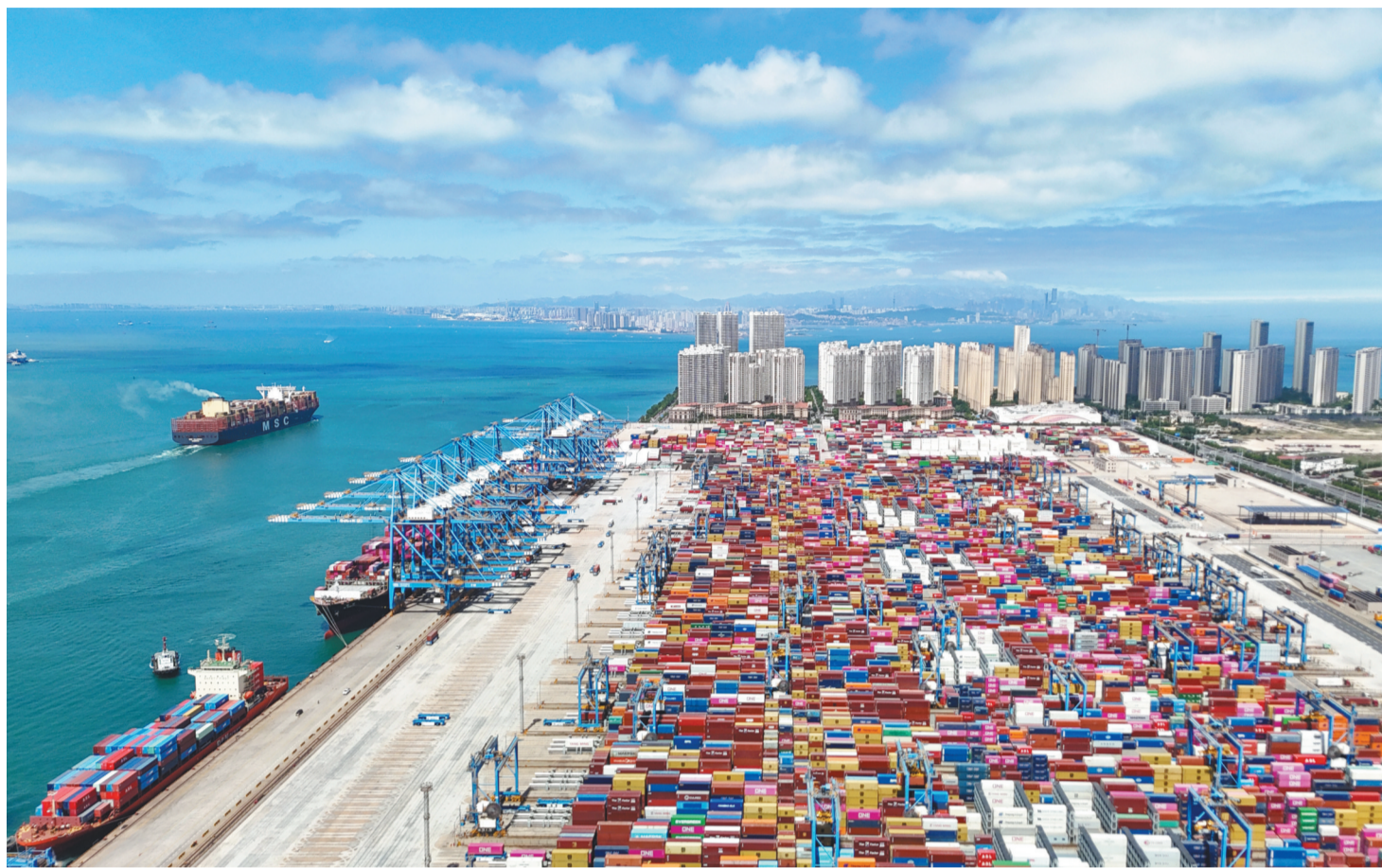
6月2日，在山东港口青岛港全自动化码头，货轮在泊位装卸集装箱（无人机照片）。
