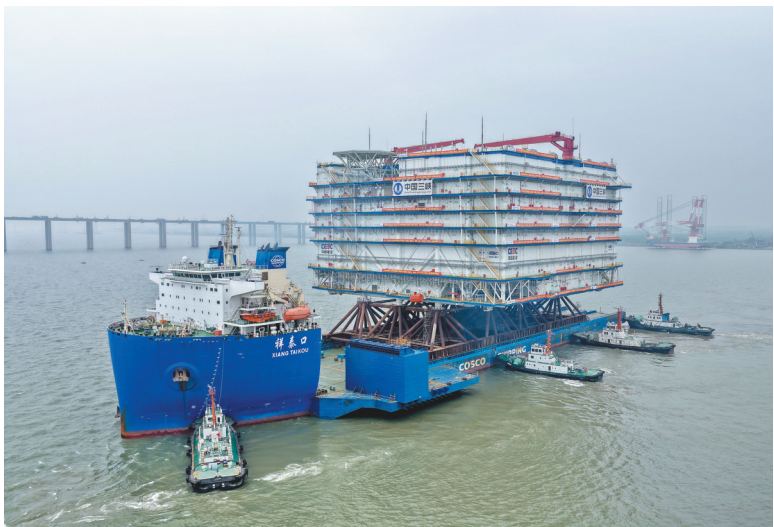
5月27日，总重约2.5万吨的超大规模海上换流站“海风之心”在江苏南通振华重装正式发运，将运往广东阳江海上风电场。
