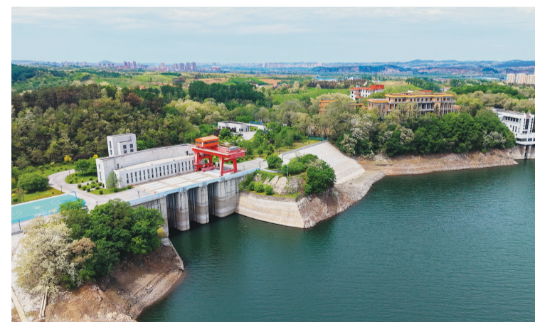
图为位于抚顺的大伙房输水工程供水首部。本报记者 白琳 摄
