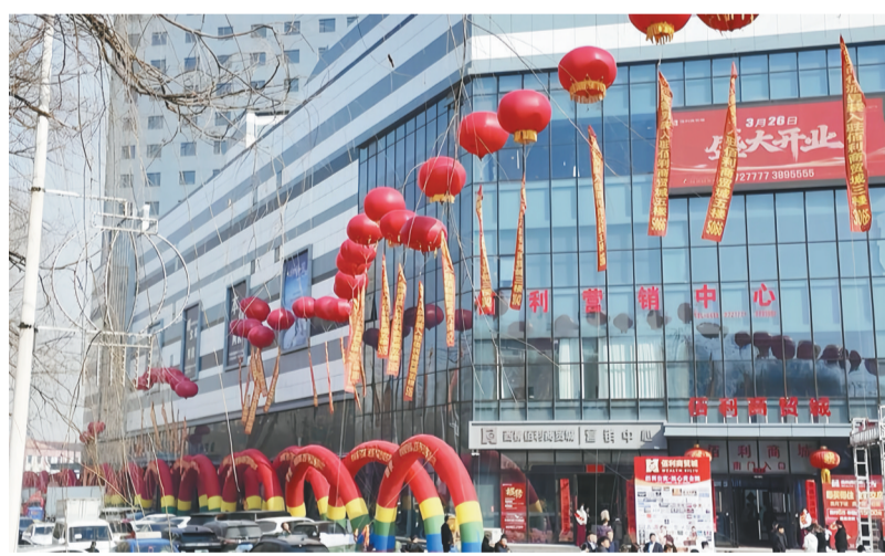
西柳镇闲置20多年的老楼焕新重启。
