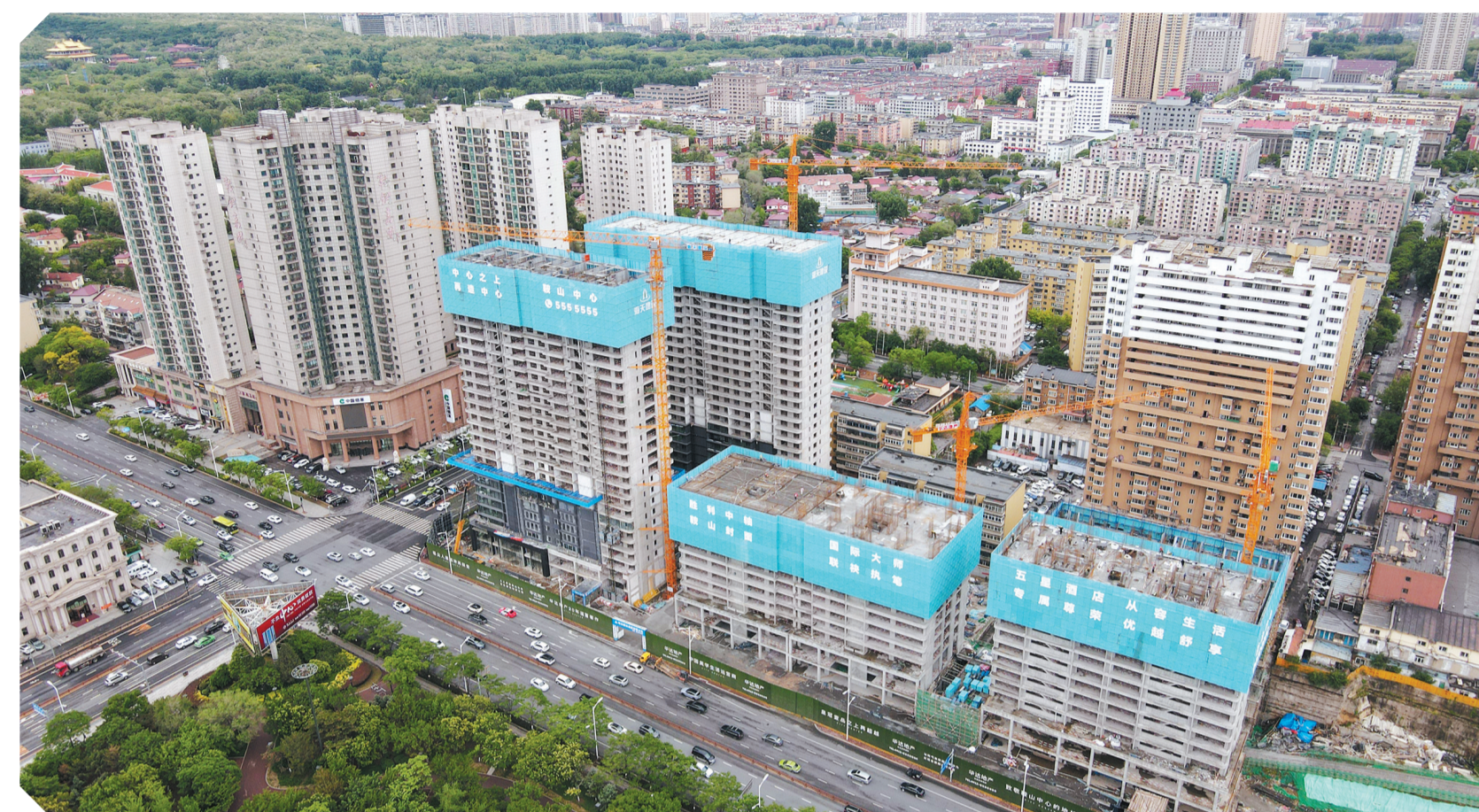
空中俯瞰建设中的“鞍山中心”。
