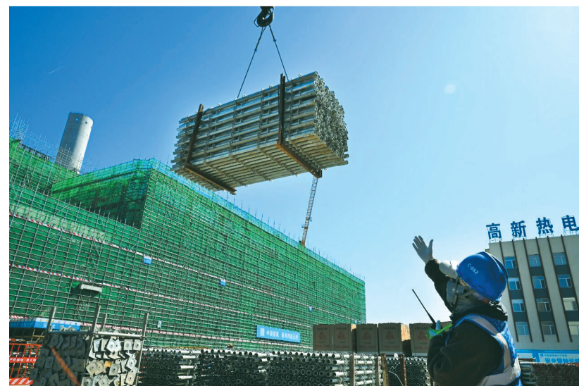
热电联产工程建设现场。本报特约记者 杜季亮 摄
