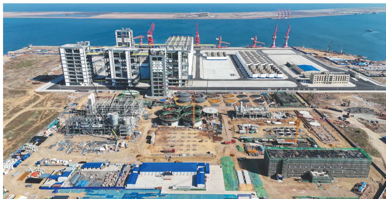
图为厦门象屿太平湾植物蛋白加工项目施工现场。
