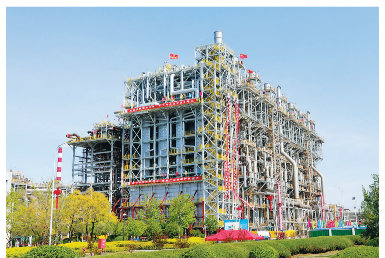
图为9号裂解炉通过平移与8号裂解炉合体。赵旭东 摄
