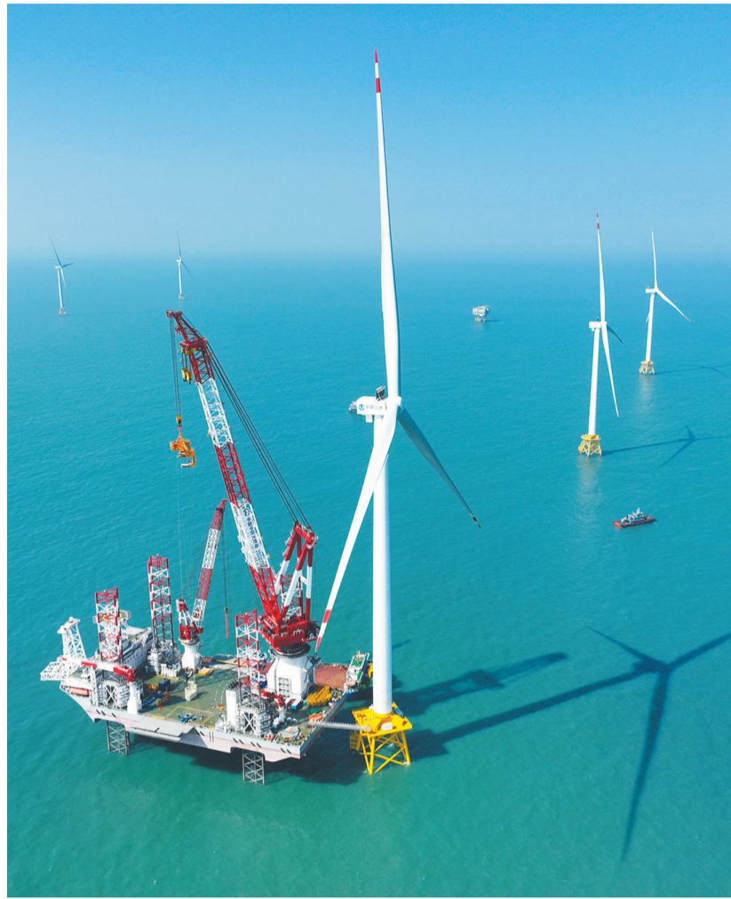
这是在福建海域拍摄的20兆瓦海上风电机组和“大桥海风”号2000吨自升式海上风电安装平台（无人机照片）。
