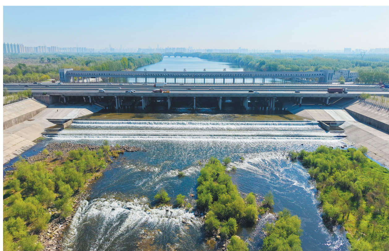
随着浑河闸抬起，生态补水缓缓流向下流。
