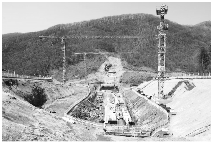
图为正在建设中的龙岗山滑雪场。 本报记者 张博 摄
