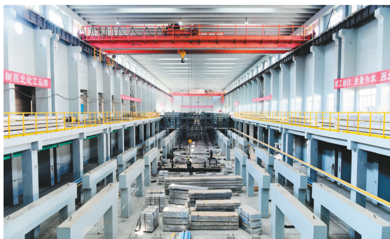
金钛股份2万吨高端航空航天海绵钛全流程项目镁电解车间正在建设中。本报特约记者 仇一军 摄
