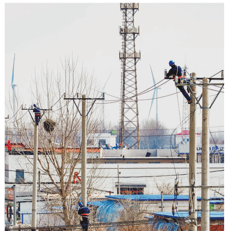
国网台安县供电公司桓洞镇10千伏线路进行升级改造,提升供电能力。唐慧宝 摄
