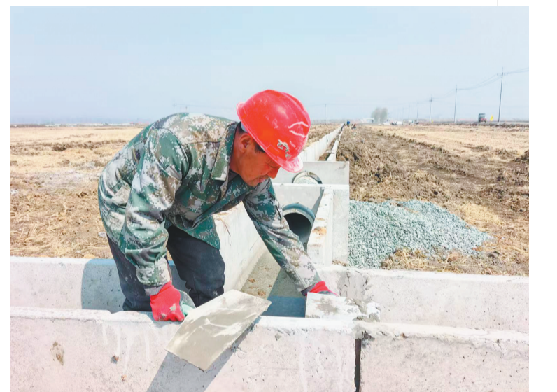
头戴红色安全帽的工人夏广平挨个查看高标准农田建设的水泥矩形槽之间接口处，并用水泥填抹平微小的缝隙。
