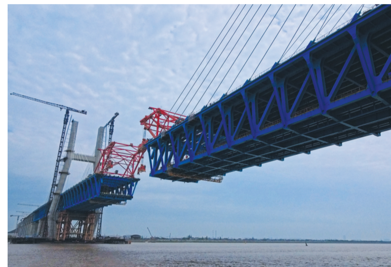
崇启公铁长江大桥是沪渝蓉高铁沪宁段关键控制性工程,全长4.09公里,横跨长江入海口北支航道,采用双层公铁两用无砟轨道斜拉桥的设计,上层为设计时速100公里的双向六车道一级公路,下层为设计时速350公里的双线高速铁路及设计时速250公里的双线城际铁路,主通航孔跨径达400米。目前大桥主跨钢梁4个节段等待吊装,预计5月下旬完成大桥合龙。
