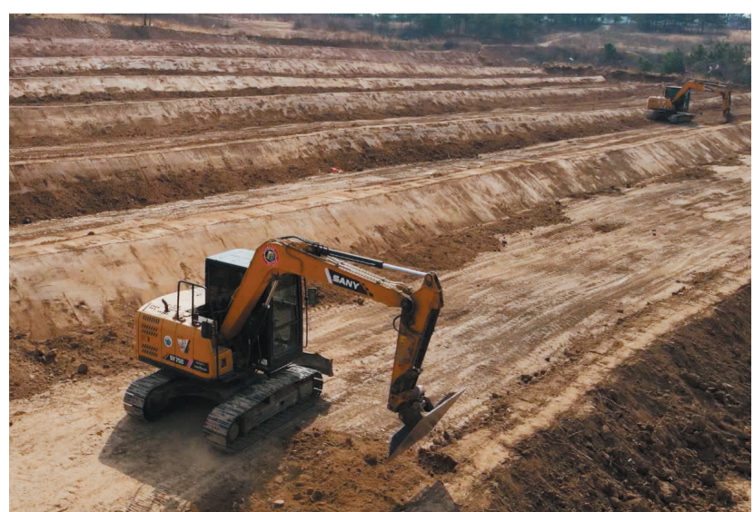
工作人员操作大型机械开展翻地作业。
