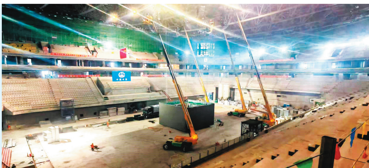
图为沈阳王家湾冰上运动中心综合馆内部施工现场。 本报记者 孙海涛 摄
