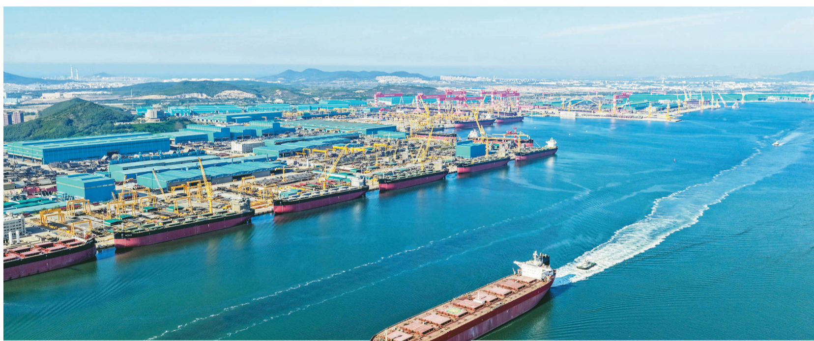
一艘超大型货轮驶出恒力重工进行海试。
