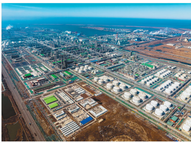
华锦阿美精细化工及原料工程项目现场。华锦阿美石油化工有限公司提供
