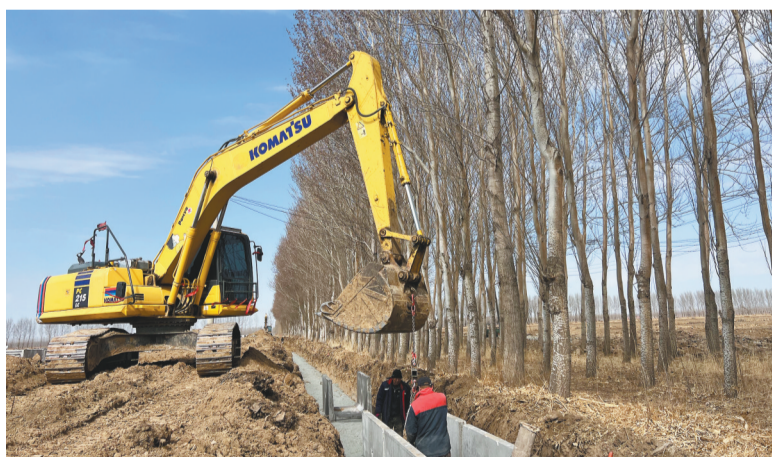
昌图县后窰镇五家堡村矩形槽排水沟铺设现场。本报记者 王晓波 摄
