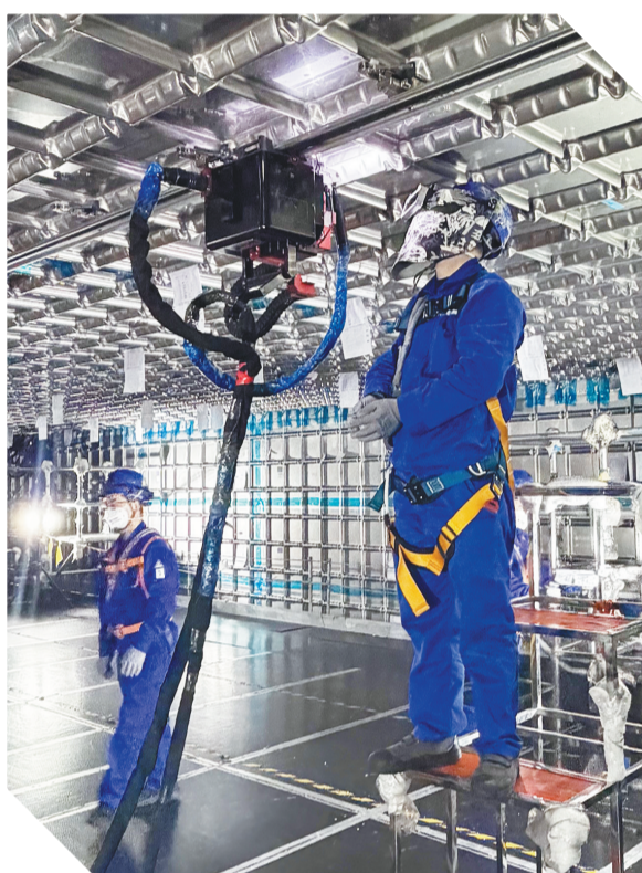
船舱焊缝加起来有1万多米长，工人们正在进行焊接。
