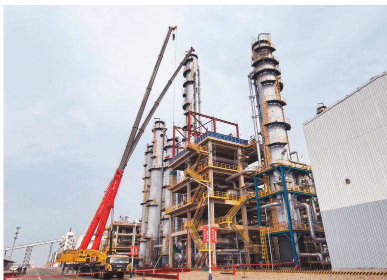
图为大唐阜新煤制天然气公司低温甲醇洗装置甲烷回收项目建设现场。本报记者 李越 摄
