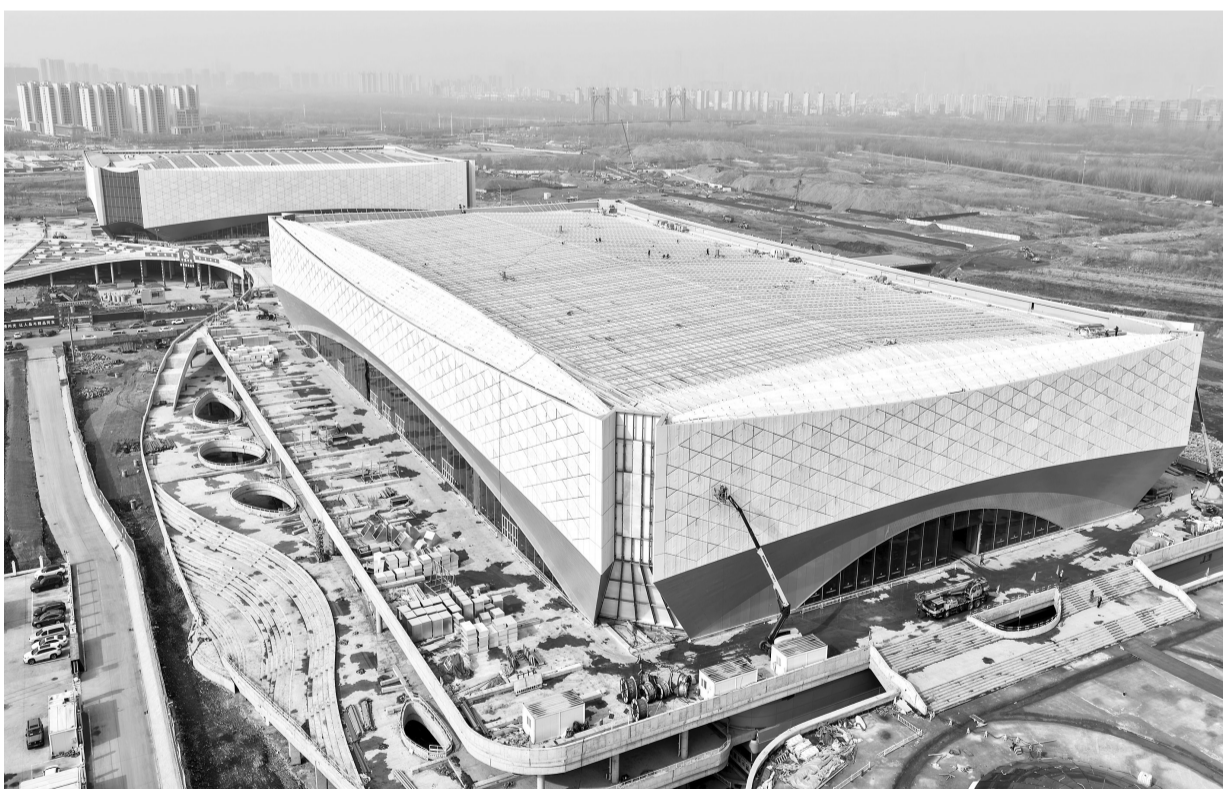
沈阳王家湾冰上运动中心建设正在火热推进中,两座冬季运动场馆及媒体中心的建筑主体已经完工。记者在现场看到,几十名工程人员正在速滑馆楼顶安装光伏发电系统的龙骨(支架),并进行外墙局部施工。
