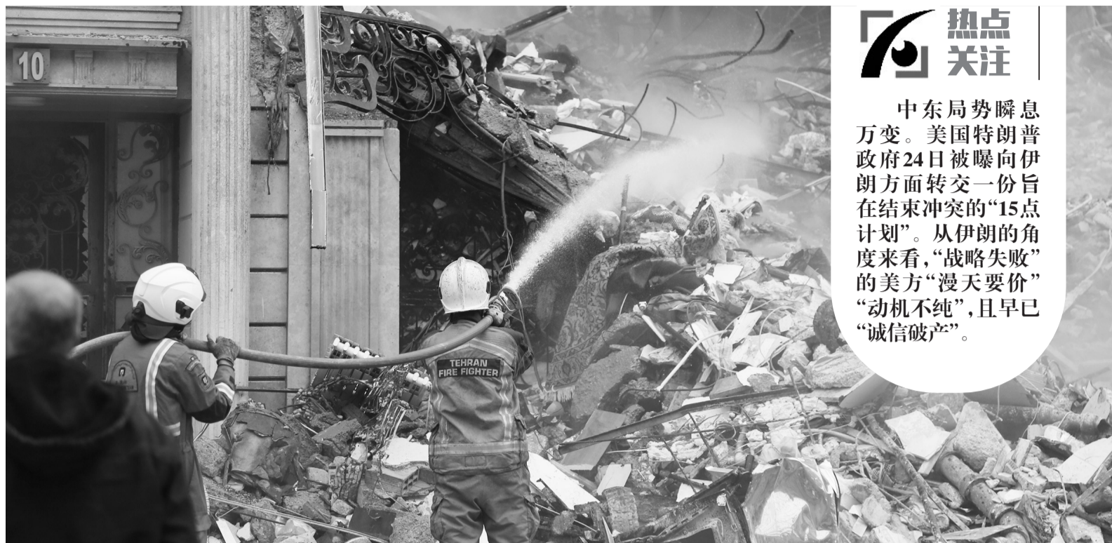
这是在伊朗德黑兰一处居民区拍摄的被毁建筑，该居民区曾在美以军事行动中遭受袭击。
