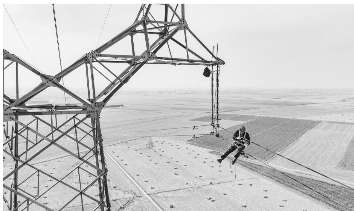
3月18日,在海城市220千伏东牛二线春季检修现场,作业人员对位移后的防震锤进行复位。 赵琦林 摄
