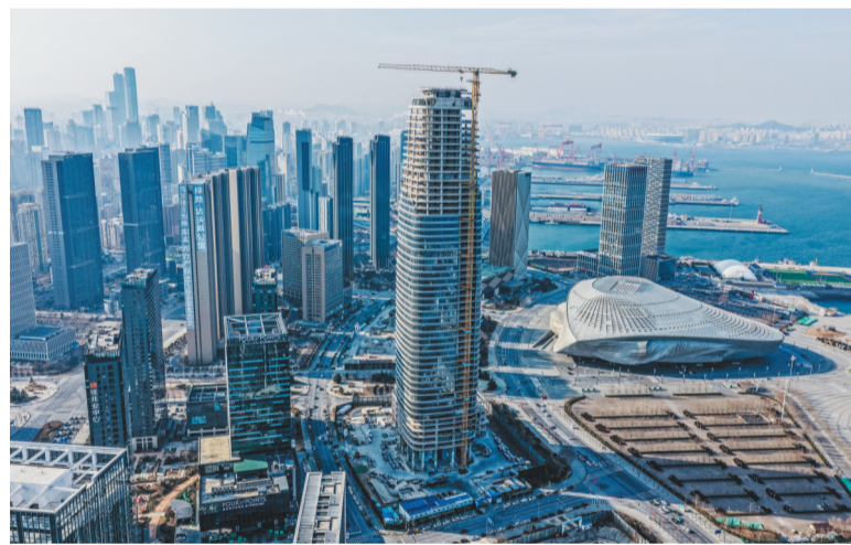
正在安装幕墙的大连国际航运中心大厦。
