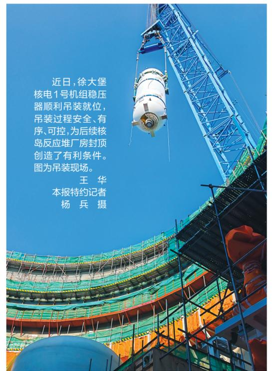
徐大堡核电一号机组稳压器吊装就位
