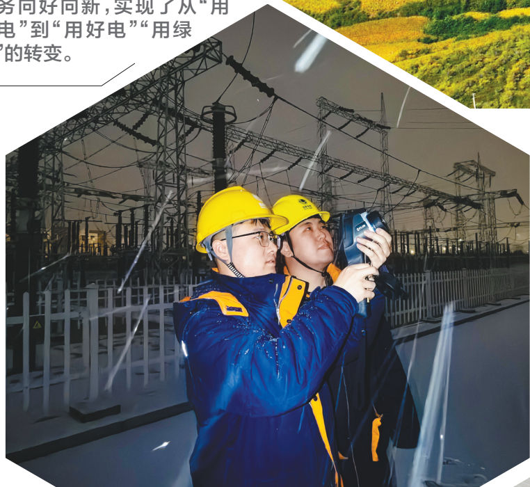
国网阜新供电公司员工对220千伏变电站开展雪后特巡。耿铭泽 摄
