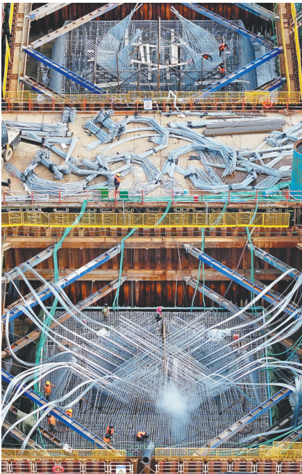
建设者在主桥承台顶部对细部钢筋进行调整。
