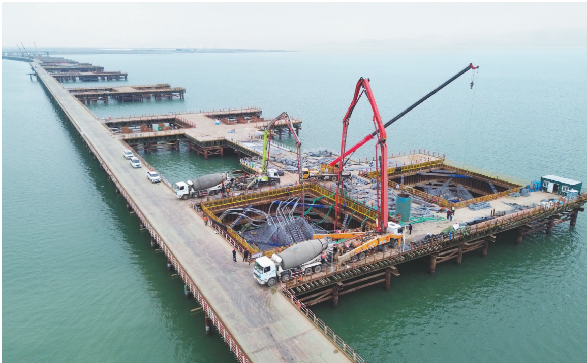
工程主桥首个承台正在浇筑。
