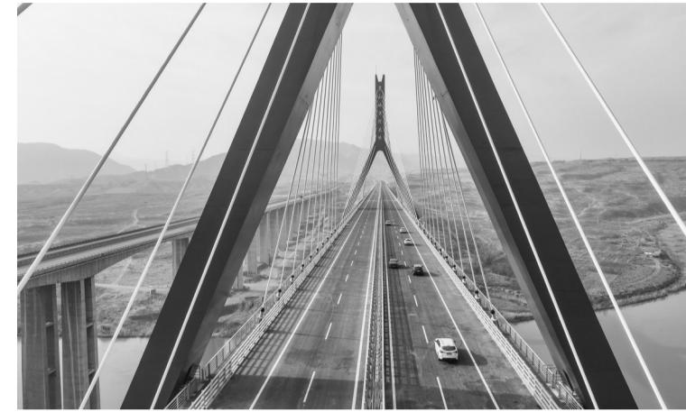
12月30日，车辆行驶在黑山峡黄河特大桥上（无人机照片）。12月30日，位于宁夏中卫市的黑山峡黄河特大桥正式通车，标志着国道338线中卫至孟家湾段公路项目投入运营。黑山峡黄河特大桥全长1539米，主跨240米，是国道338线中卫至孟家湾段项目控制性工程。
