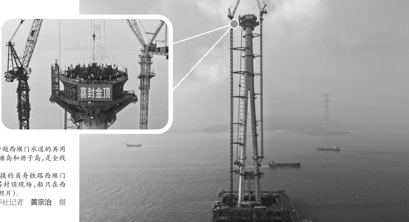
12月30日，由中铁大桥局承建的甬舟铁路西堠门公铁两用大桥5号主塔封顶，这是甬舟铁路全线首座封顶的桥梁主塔。294米高的主塔，大约相当于100层楼房的高度，刷新了世界海中桥梁主塔高度的纪录。
