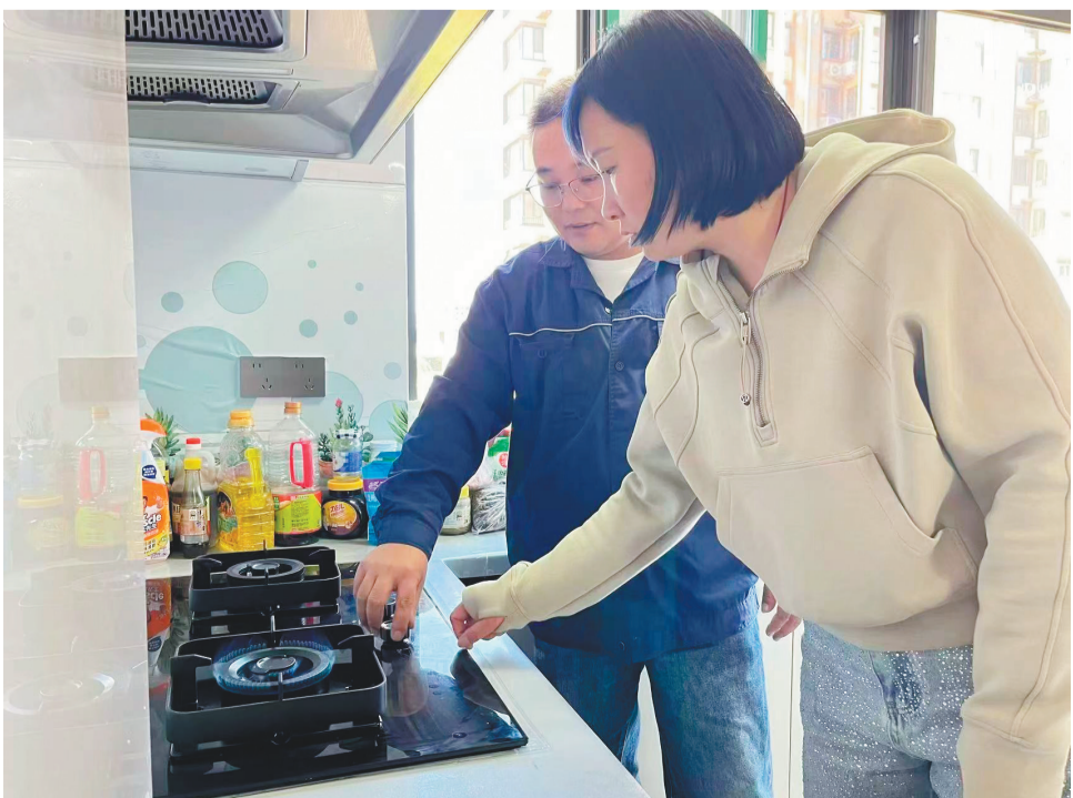
鼎盛公寓居民用上安全便捷的天然气。
