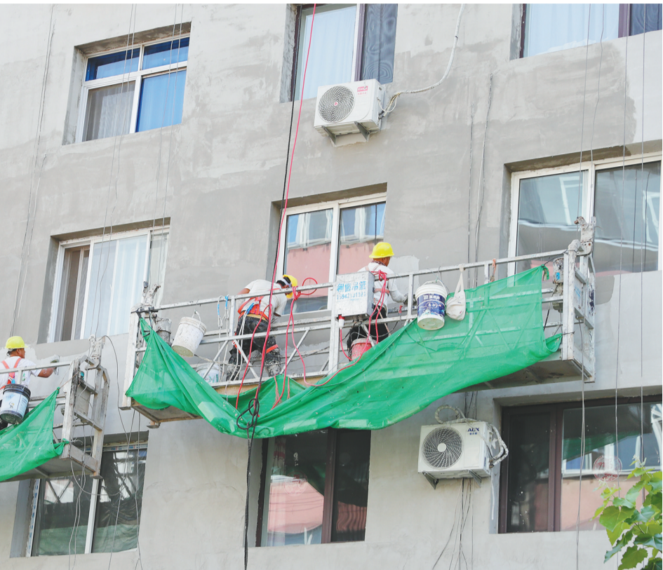
左图:改造后的博南小区焕然一新。上图:施工人员正在为北市南小区做外墙保暖。
