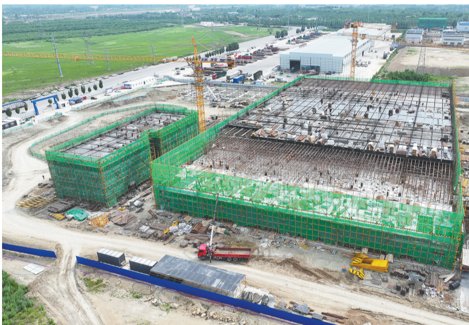
朝阳利澳卫生用品智慧生产项目施工现场。
